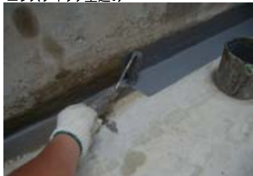
エラストイック仕上げ
