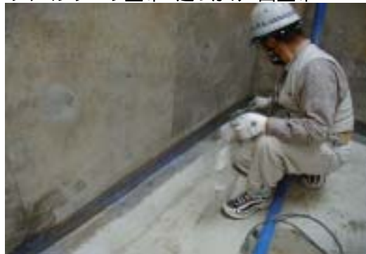
エラストイック塗込み
