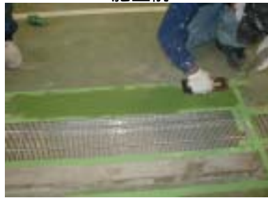
ステリコー HUC施工
