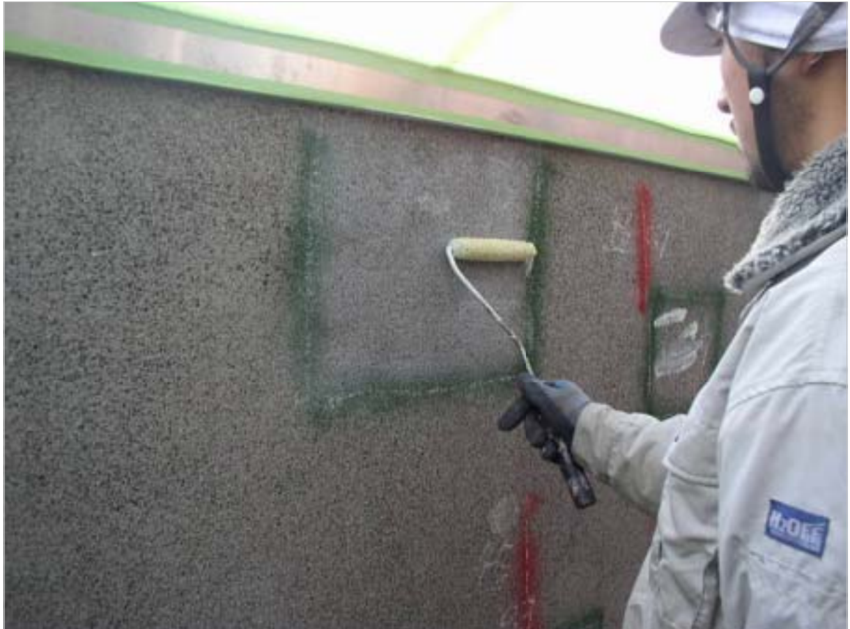
ボンディングプライマー塗布状況
