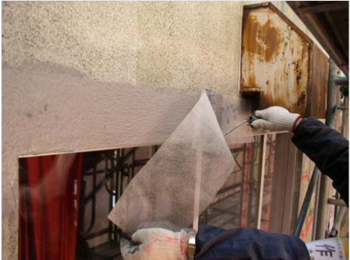
リーマット貼り状況
