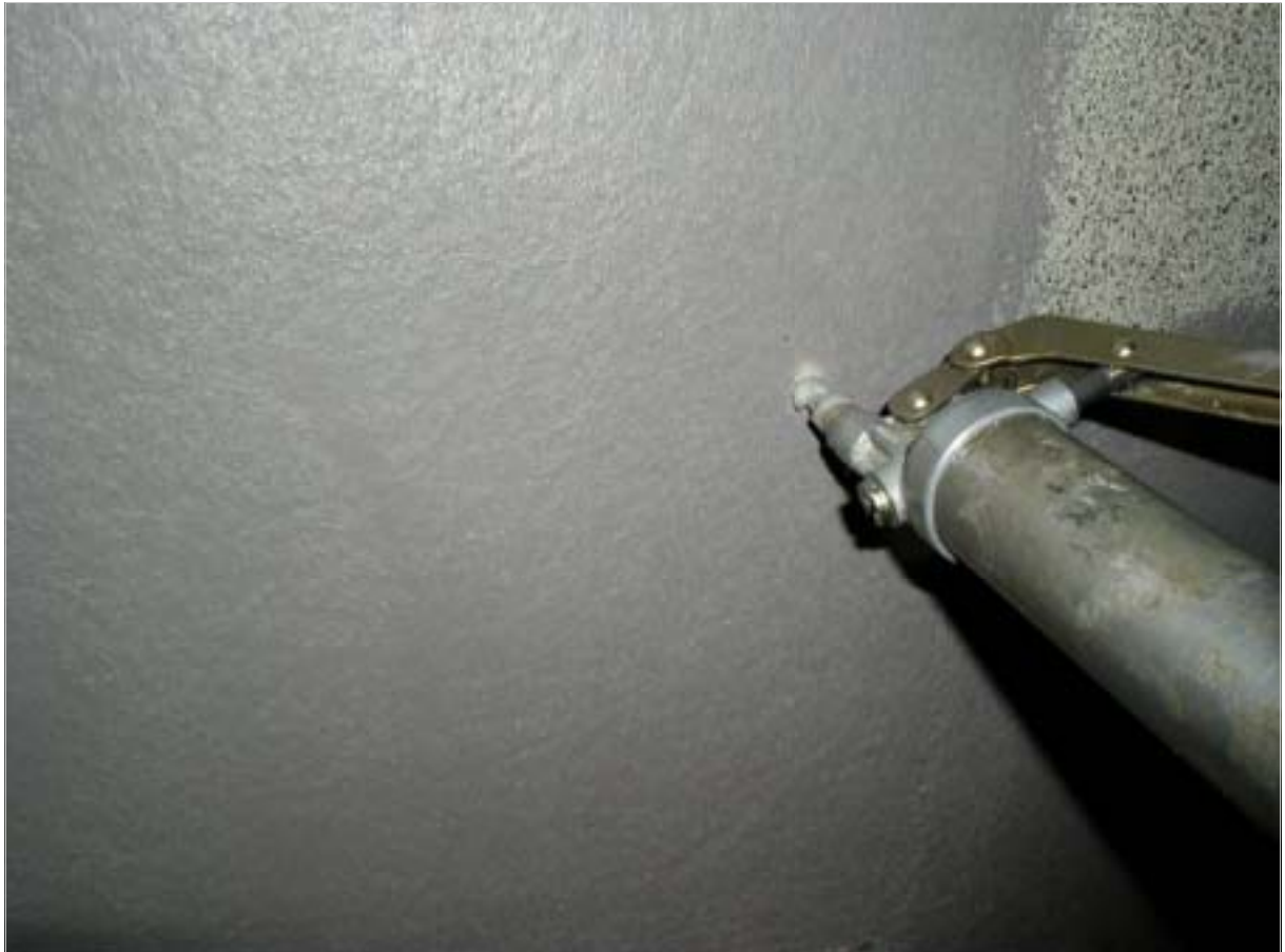
エポキシ樹脂注入状況
