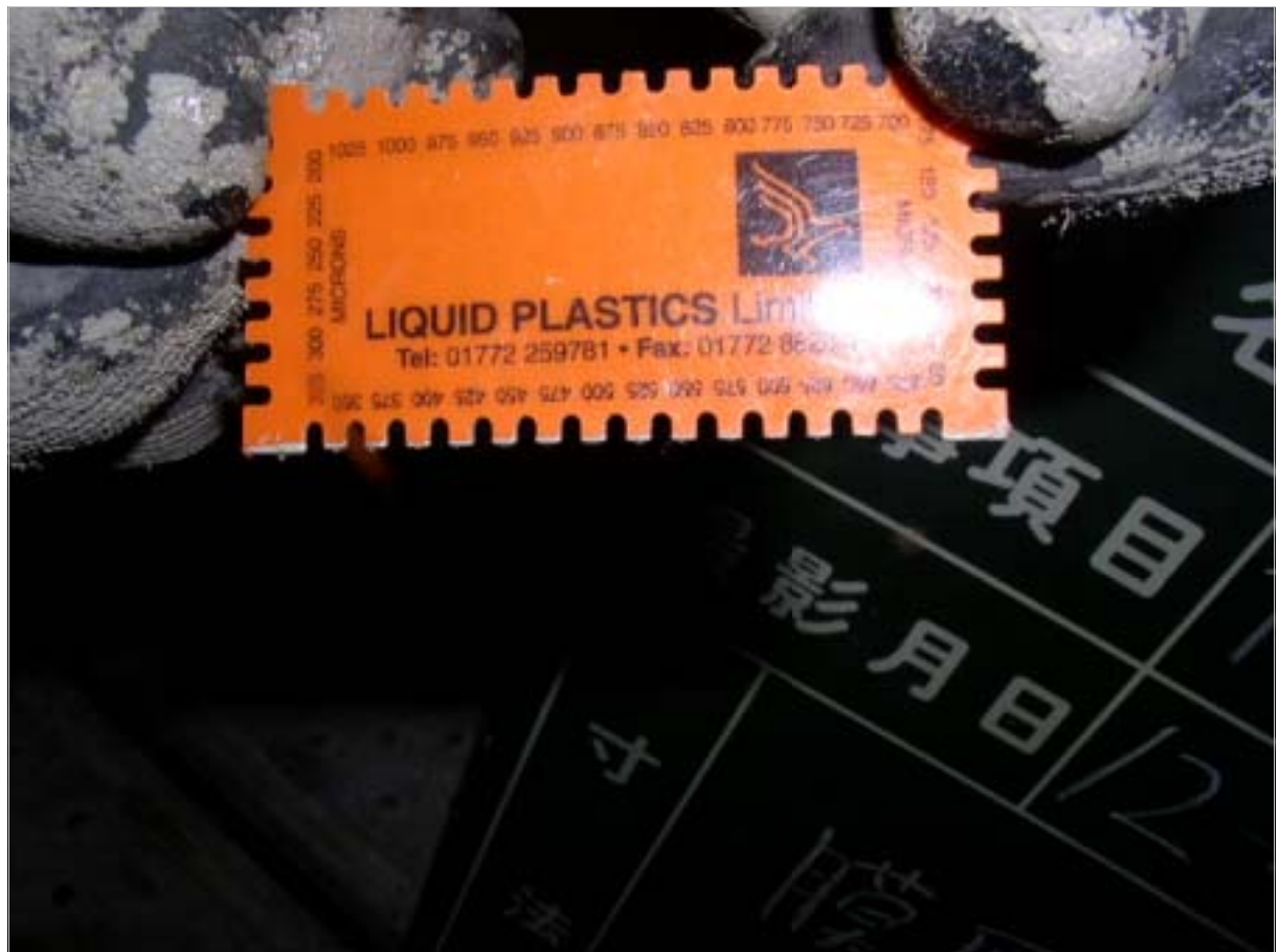
ウエットゲージによる塗布量管理
