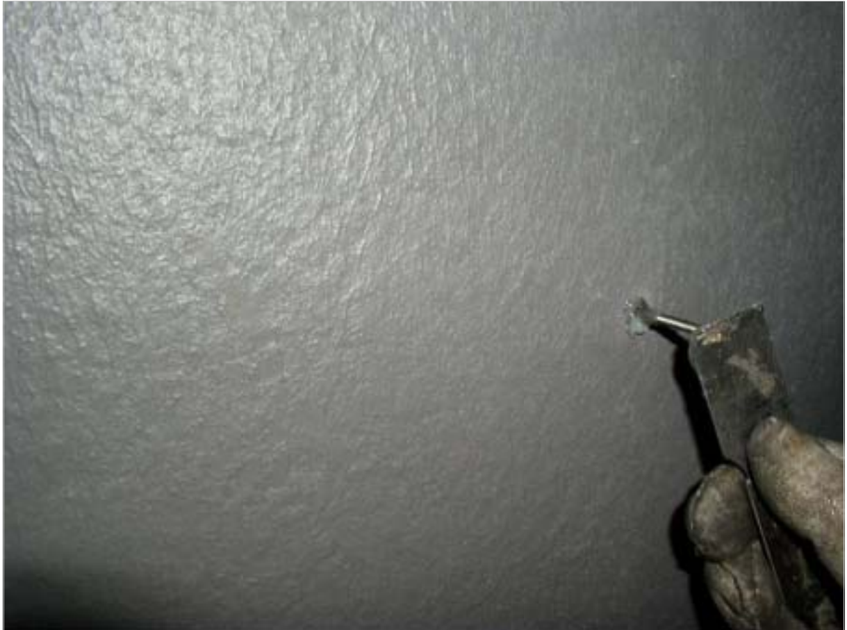
ステンレスアンカーピン差し込み状況
