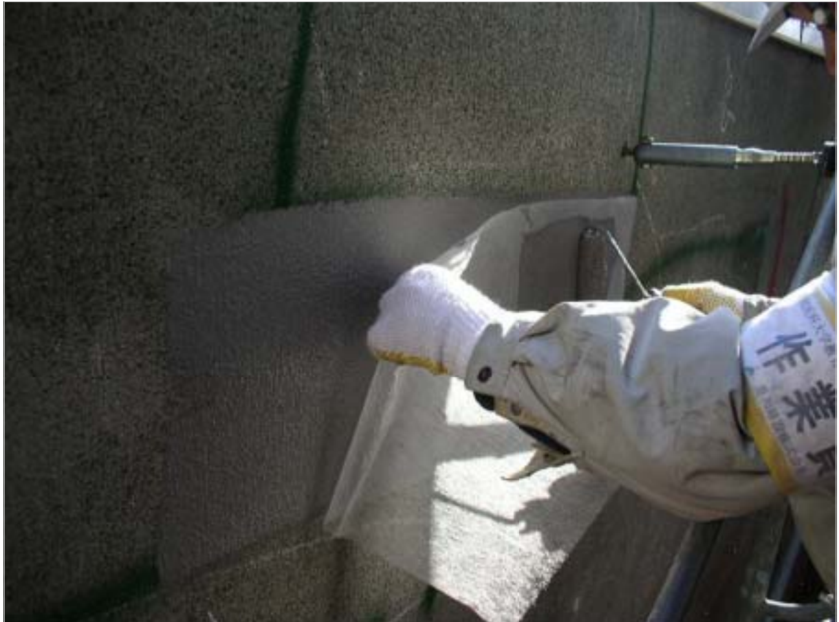
リーマット貼り状況
