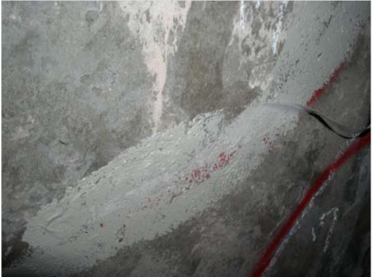
リーマット貼り・押え塗り状況
