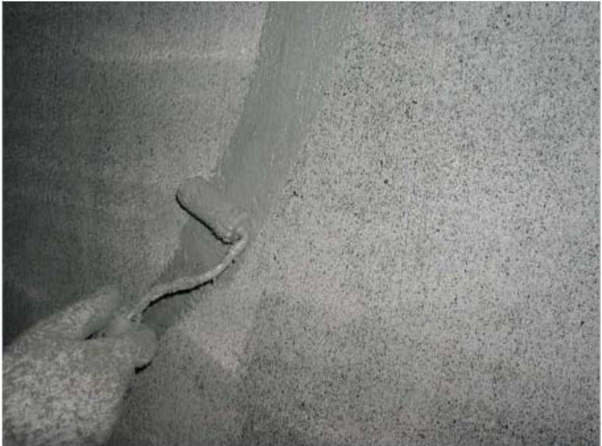
デカデックス仕上げ塗り状況
