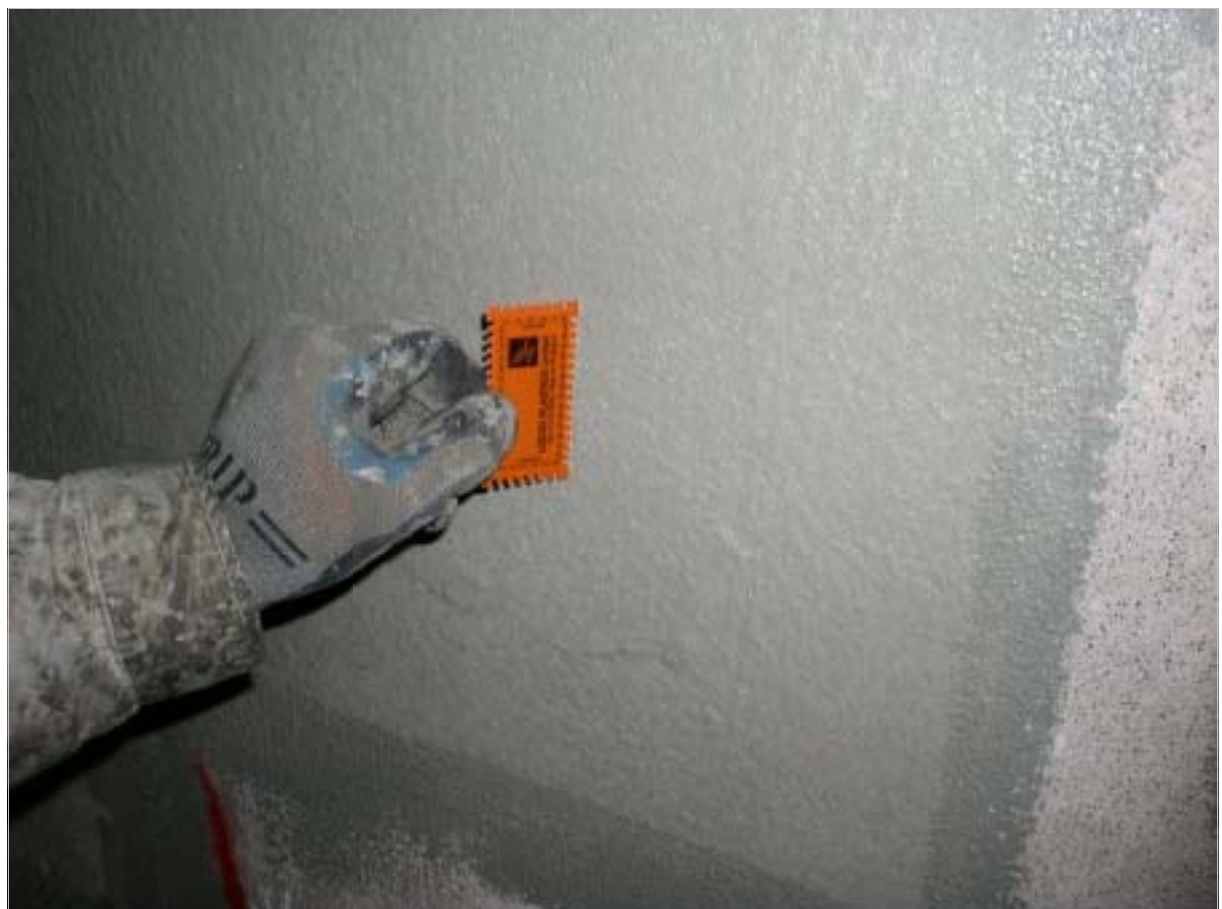
ウエットゲージによる塗布量管理
