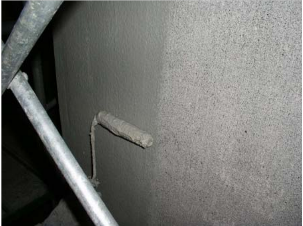
デカデックス仕上げ塗り
