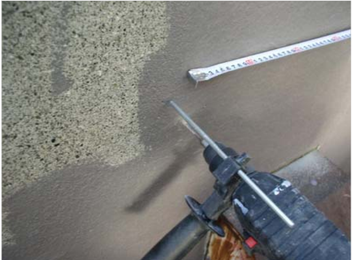
アンカーピン穴あけ状況
