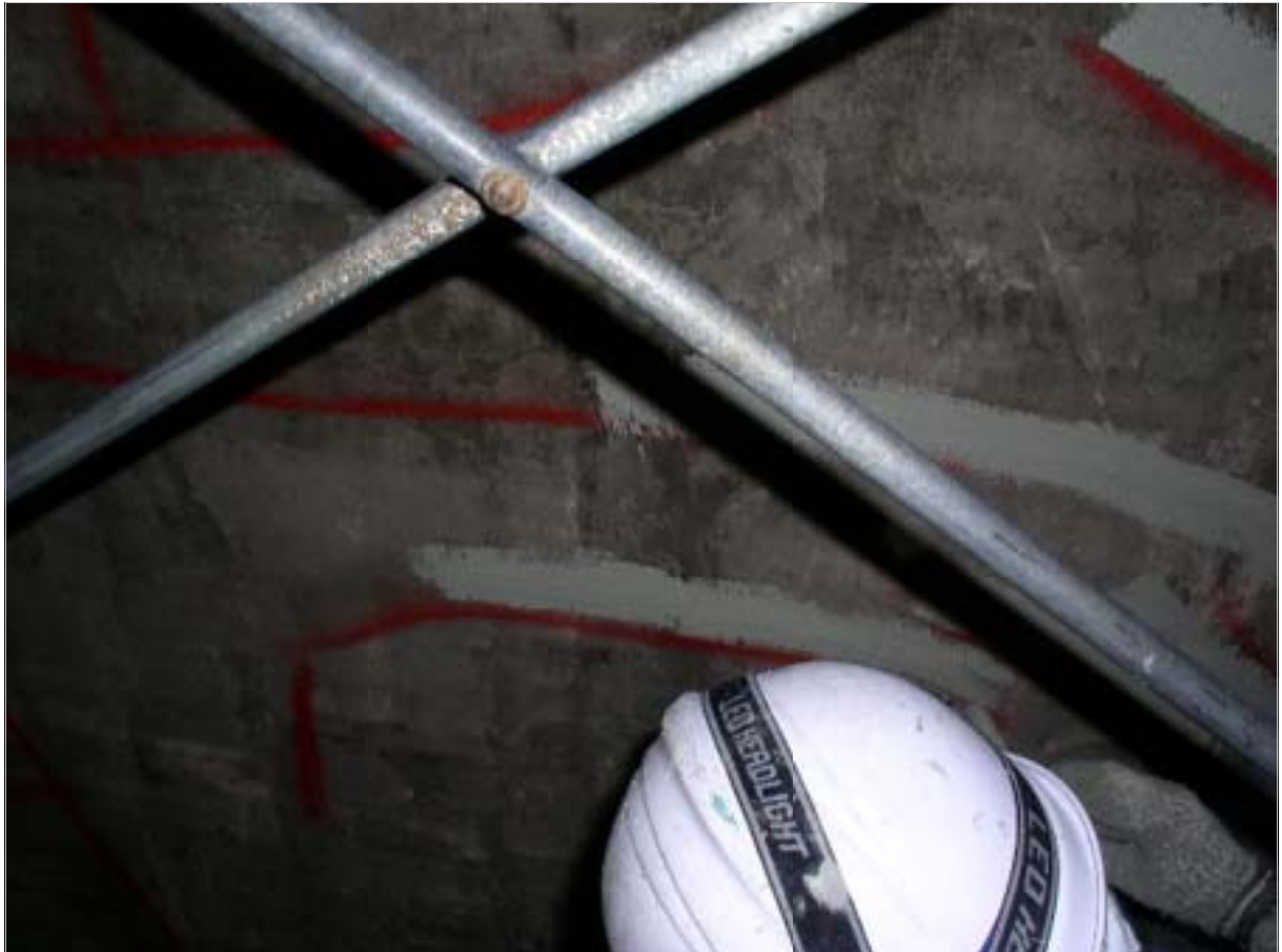
クラック面デカデックス塗込み状況
