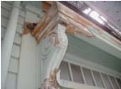
1997年LPL社デカデックスを採用9年の経過、旧塗膜白亜鉛B調合ペイントからの剥離1/3をはがし施
