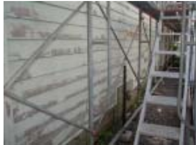
1997年LPL社デカデックスを採用9年の経過、旧塗膜白亜鉛B調合ペイントからの剥離1/3をはがし施
