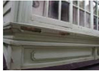
1997年LPL社デカデックスを採用9年の経過、旧塗膜白亜鉛B調合ペイントからの剥離1/3をはがし施
