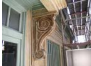
今回、剥離には、環境対応型軟化剥離剤併用高圧温水塗膜剥離洗浄工法(IMI/NHS工法)を採用し
