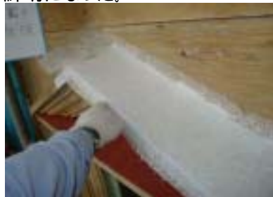
天端・切付け・腐食部分のリーマット工法により補強された。
