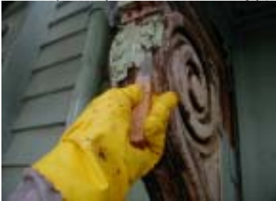
今回、剥離には、環境対応型軟化剥離剤併用高圧温水塗膜剥離洗浄工法(IMI/NHS工法)を採用し
