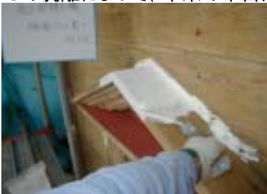
天端・切付け・腐食部分のリーマット工法により補強された。
