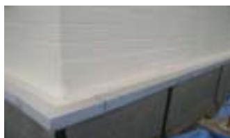
施工後：磁器タイル面.ステンレス部分注入併用リーマット工法1,640㎡
