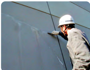
1. 外壁面の白華(エフロ)除去
