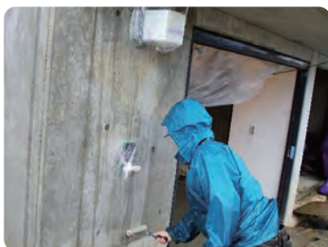
長岡市市営住宅新築工事(旧山古志村) コンクリート基礎のクラック防止と凍結融解劣化防止の目的でナノコンシーラを塗布。
