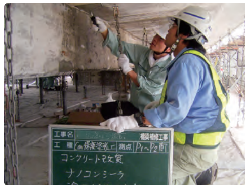
橋梁の補修工事。コンクリート部位の改質目的のためにナノコンシーラを塗布。
