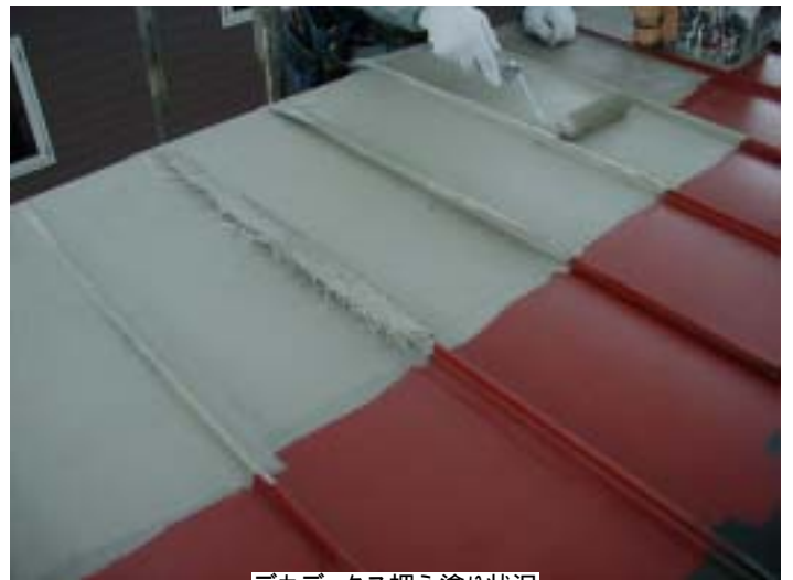
デカデックス押え塗り状況
