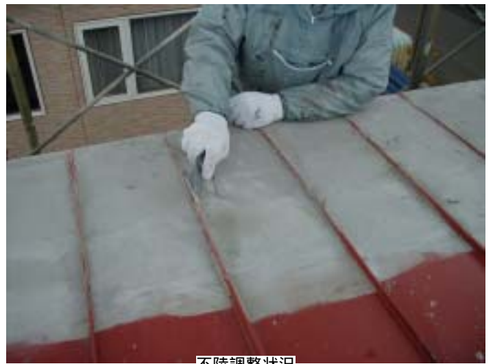
不陸調整状況
