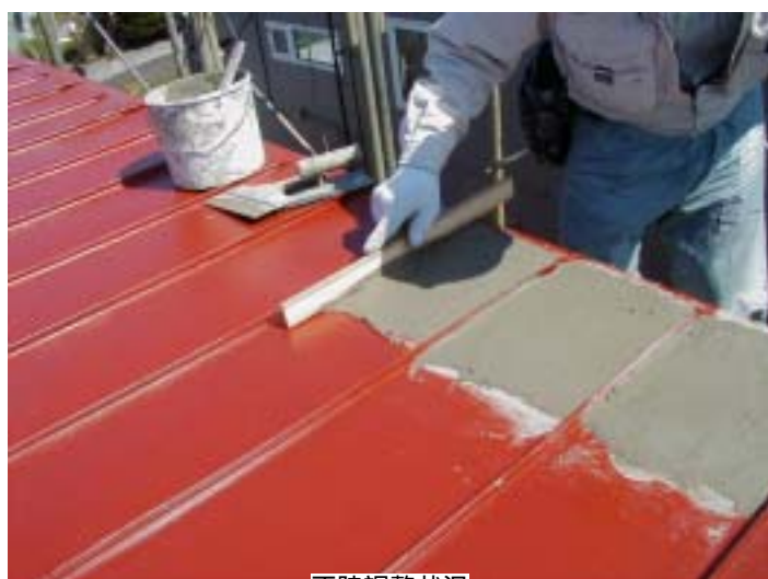
不陸調整状況
