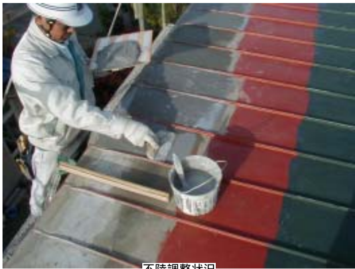
不陸調整状況
