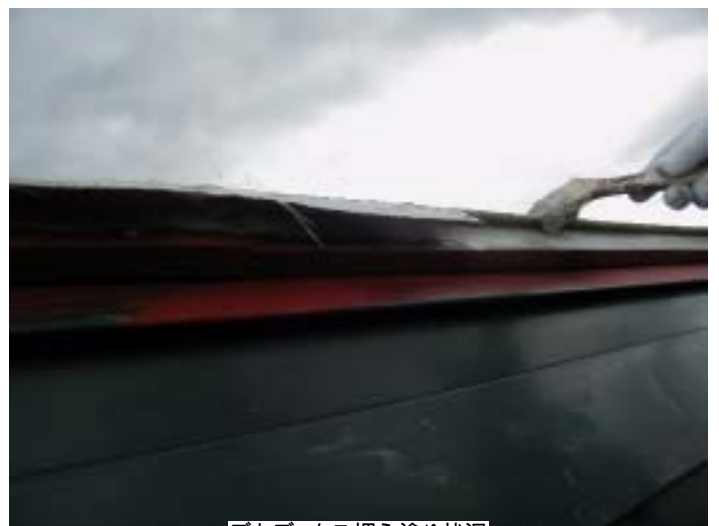
デカデックス押え塗り状況
