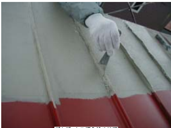
デカデックス押え塗り状況
