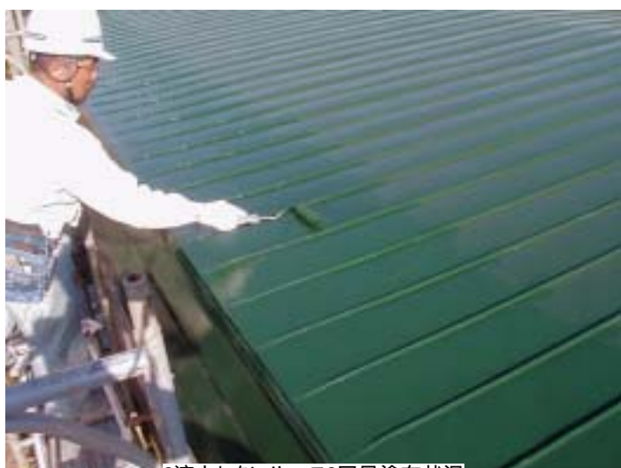
2液ウレタンルーフ2回目塗布状況
