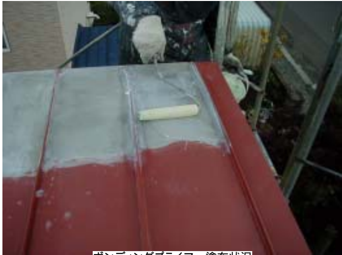
ボンディングプライマー塗布状況
