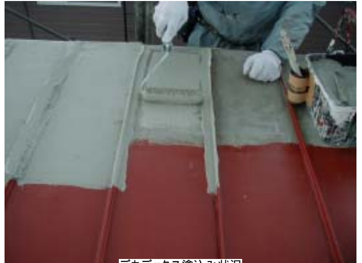
デカデックス塗込み状況
