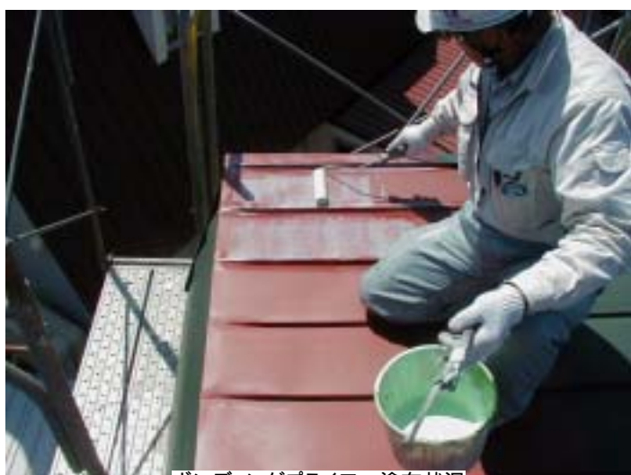
ボンディングプライマー塗布状況
