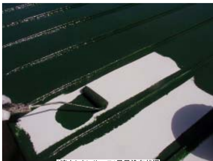
2液ウレタンルーフ1日目塗布状況
