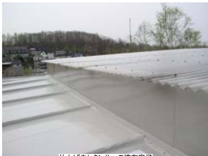
仕上げウレタンルーフ塗布完了
