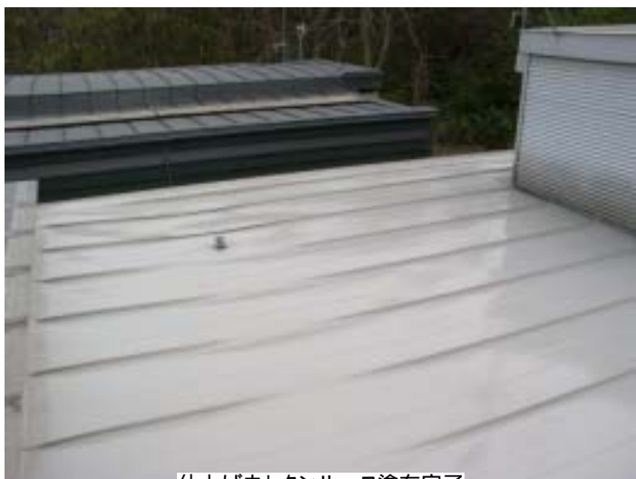
仕上げウレタンルーフ塗布完了
