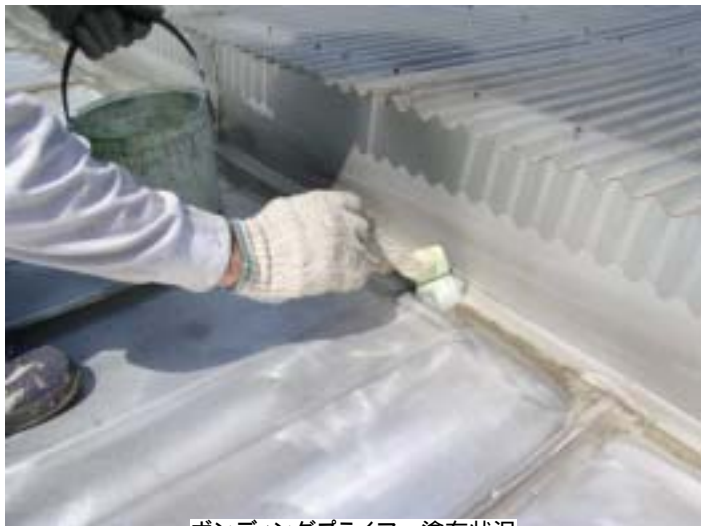
ボンディングプライマー塗布状況
