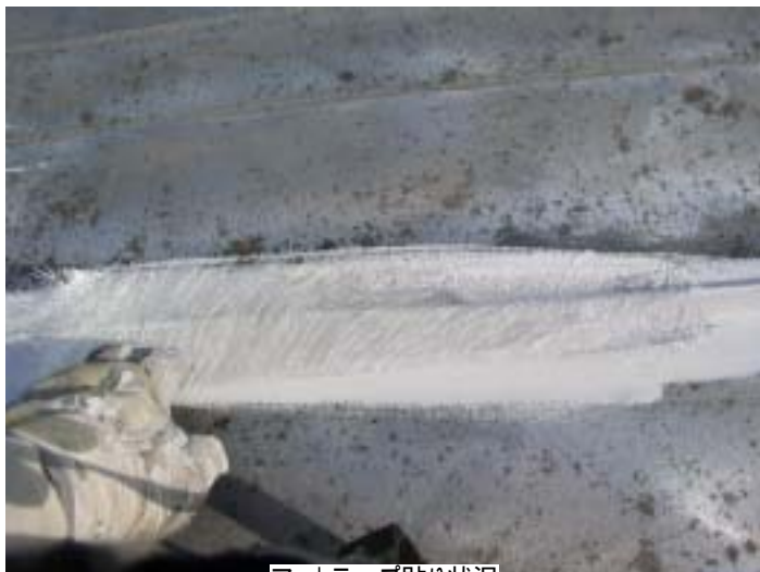
マットテープ貼り状況
