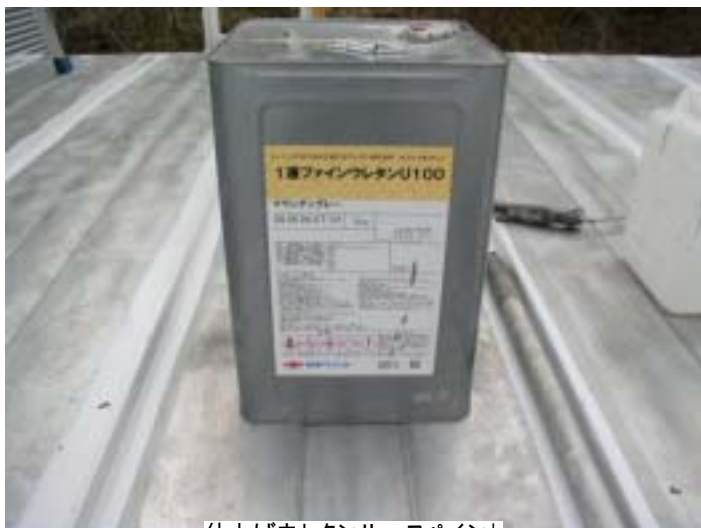
仕上げウレタンルーフペイント
