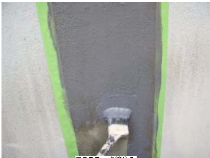
エラストック塗込み
