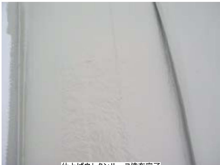
仕上げウレタンルーフ塗布完了
