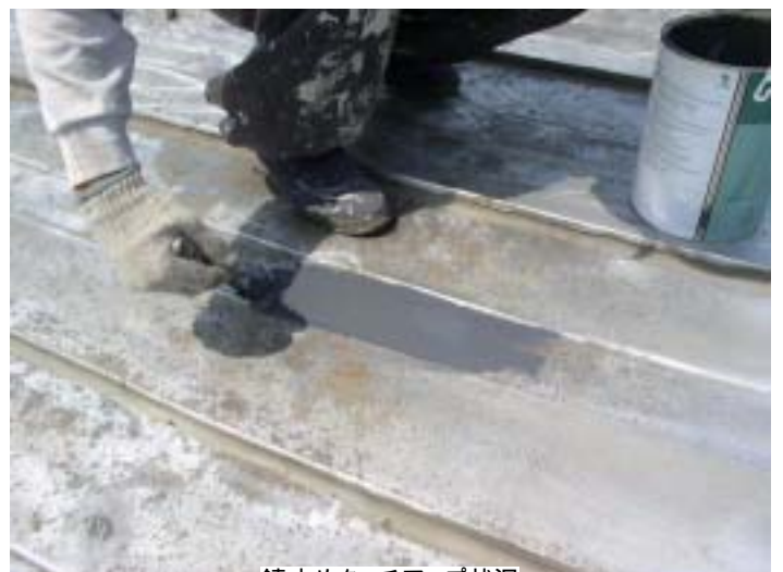
錆止めタッチアップ状況
