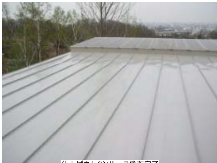
仕上げウレタンルーフ塗布完了
