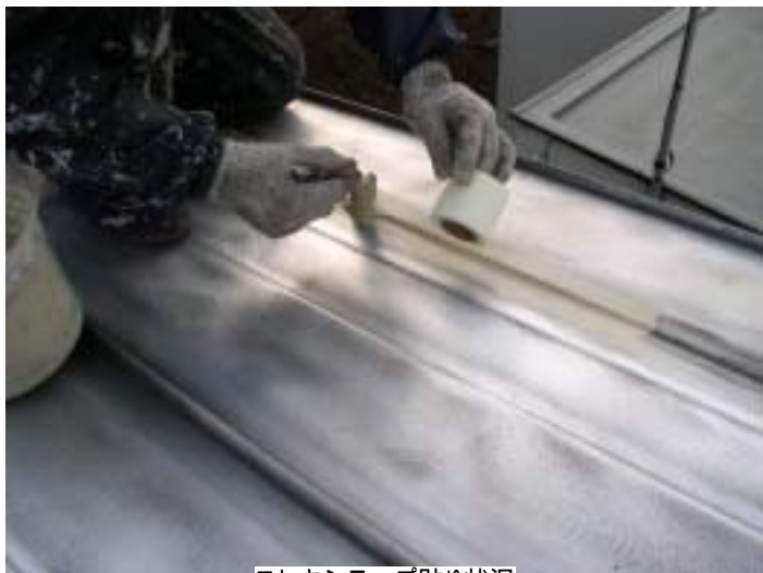
フレキシテープ貼り状況
