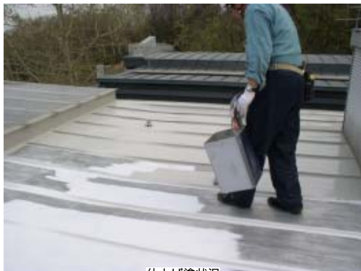
仕上げ塗状況
