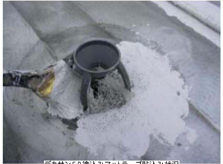
デカサンSP塗込みマットテープ貼込み状況
