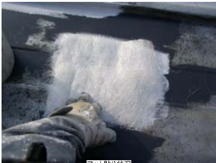
マット貼り状況
