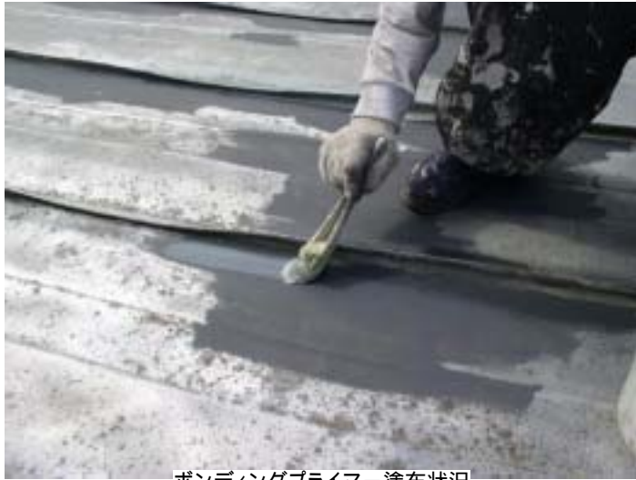
ボンディングプライマー塗布状況
