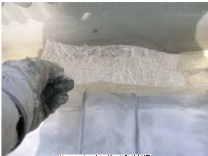
リーマットスタンダード貼り状況
