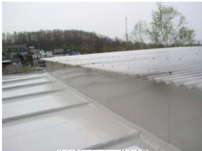
仕上げウレタンルーフ塗布完了
