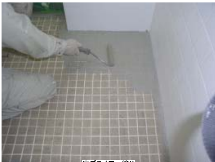
床プライマー塗り
