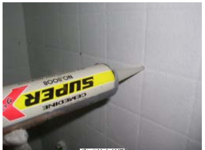
ボンド注入状況
