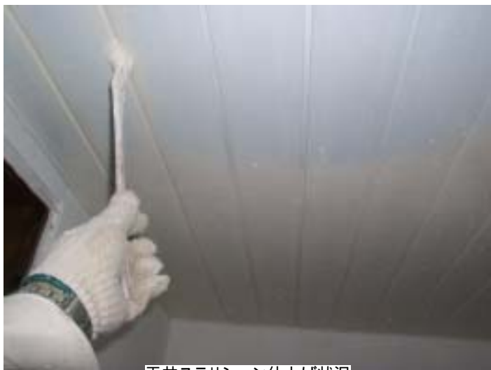
天井ステリシーン仕上げ状況
