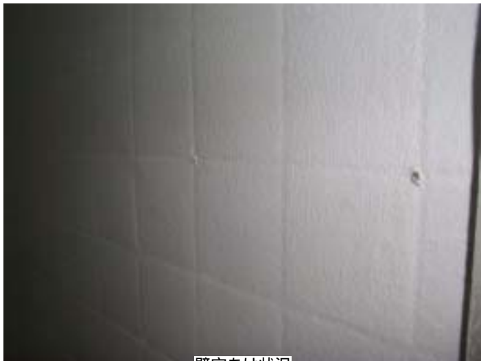
壁穴あけ状況
