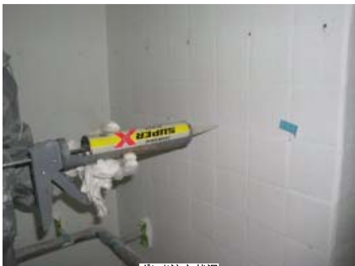
ボンド注入状況
