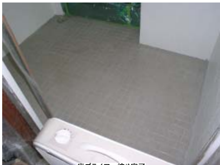
床プライマー塗り完了
