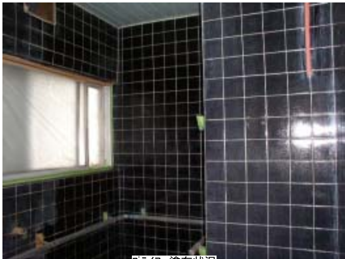
プライマー塗布状況
