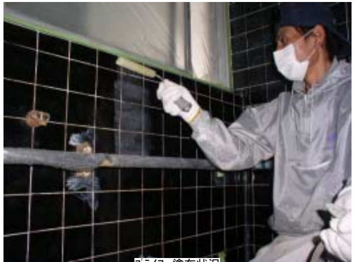
プライマー塗布状況
