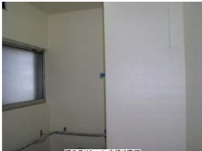
壁ステリシーン中塗り完了
