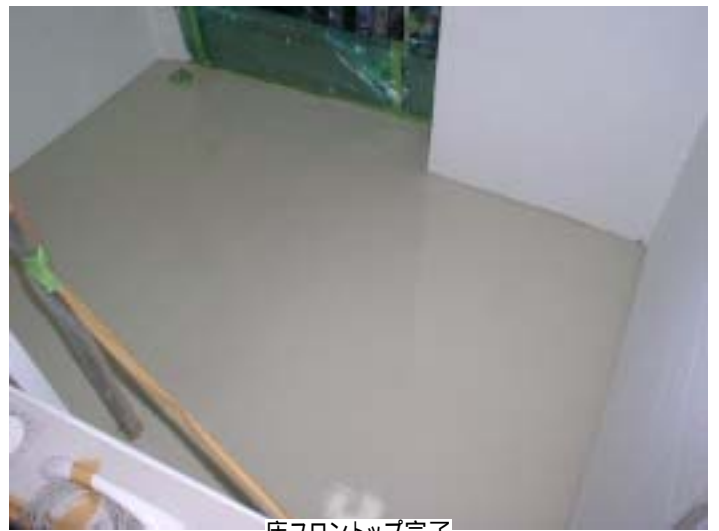
床フロントップ完了
