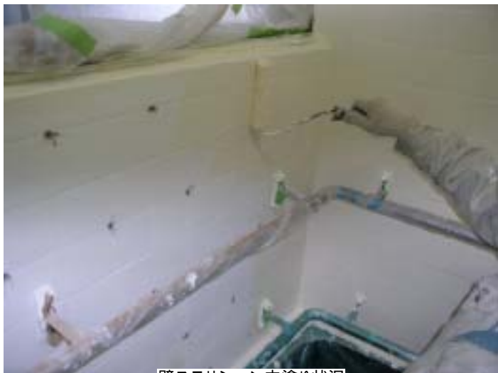
壁ステリシーン中塗り状況
