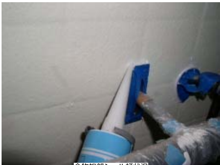
金物端部シール打状況
