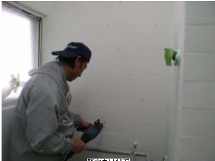
壁穴あけ状況
