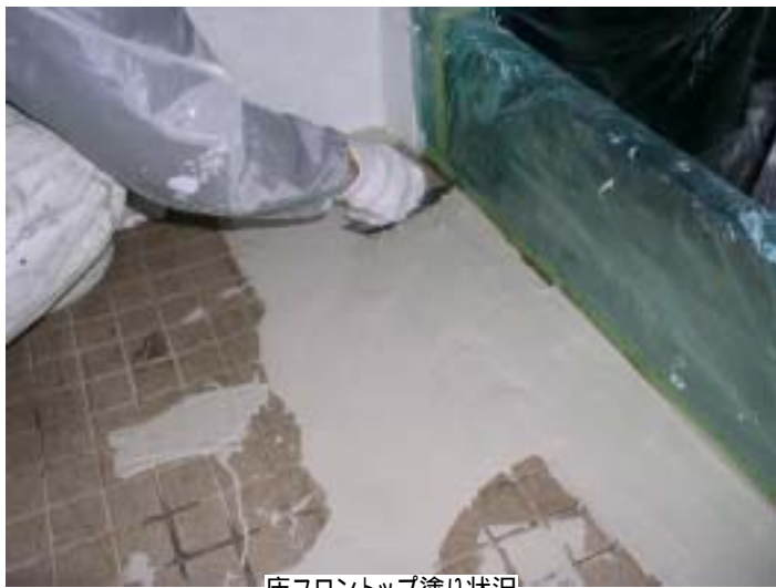
床フロントップ塗り状況
