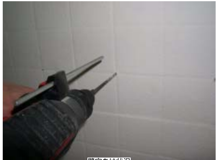
壁穴あけ状況
