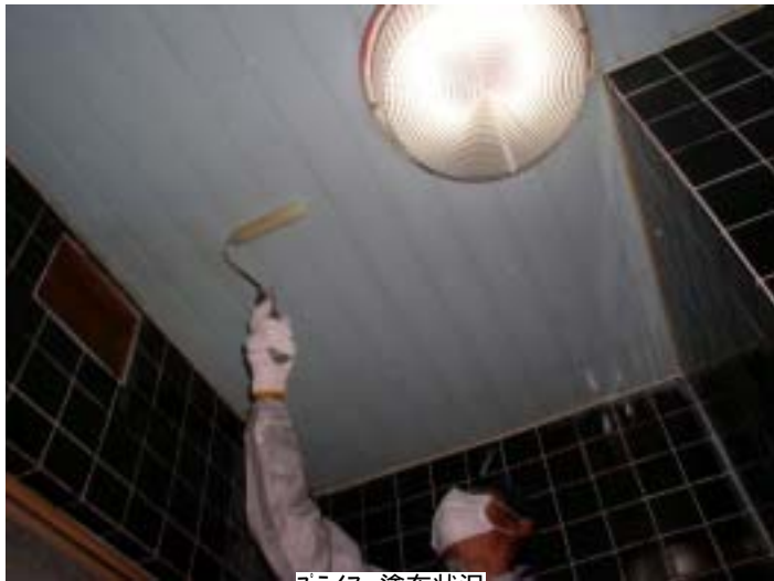
プライマー塗布状況
