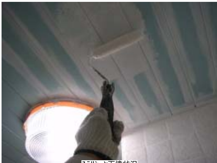
ステリシーン下塗状況
