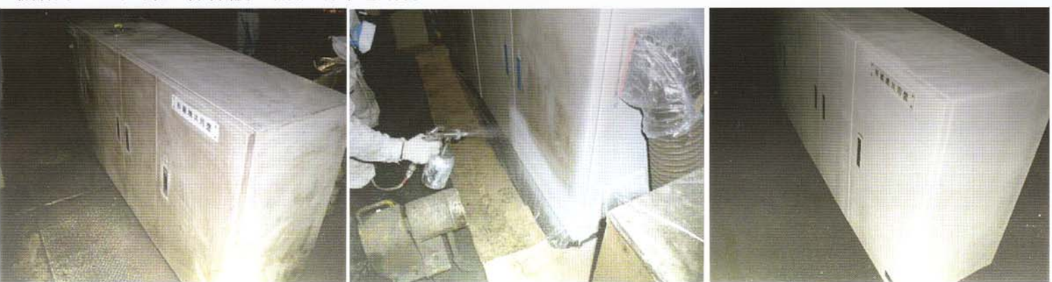
機械などの内部配線保護や耐熱効果を期待し、同時にやけど対策にも効果を発揮します。(ガン噴き2mm厚)
