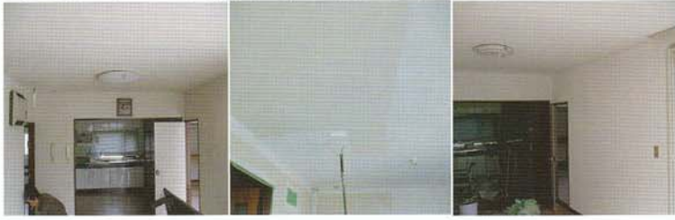
室内のクロス天井・壁面 断熱効果 ローラー2回塗り
