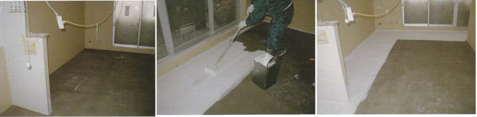
新築マンションなどの外周廻り結露対策 ローラー2回塗り、従来増CON・発砲ウレタン・ラスモルと比べ、工期短縮の効果も
