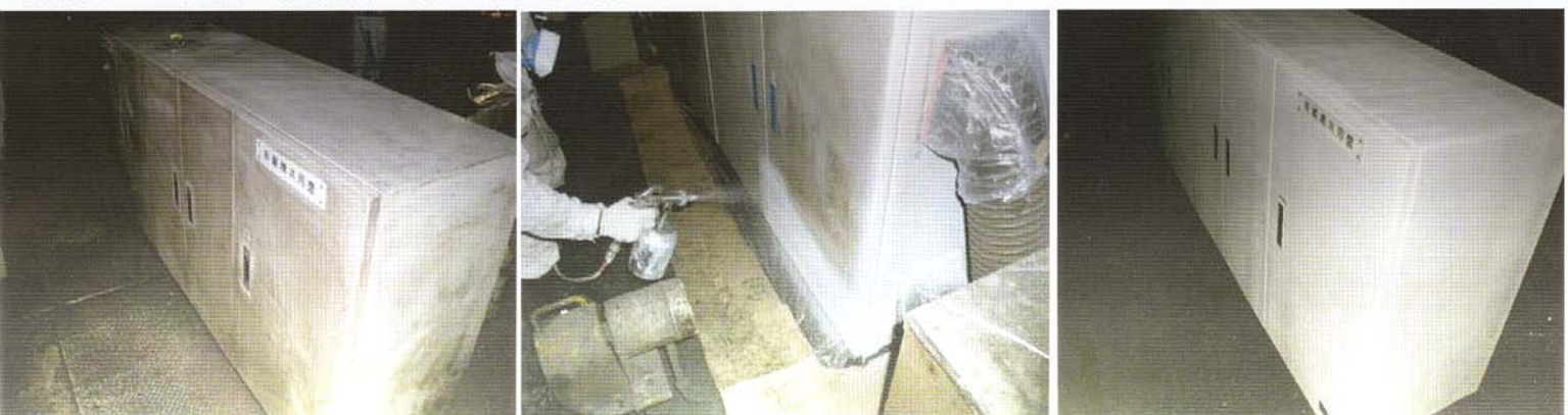
機械などの内部配線保護や耐熱効果を期待し、同時にやけど対策にも効果を発揮します。(ガン噴き2mm厚)
