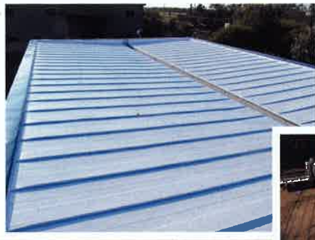
屋根への施工。太陽熱を90% 反射し、雪庇防止にも役立つ
