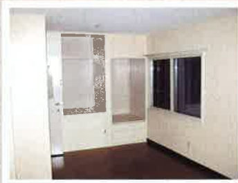
内装への塗装にも使用可能。 壁面のほか、天井や床下の 断熱材と替えたり、断熱材に 直接吹き付けて断熱性能を 上げる利用方法も
