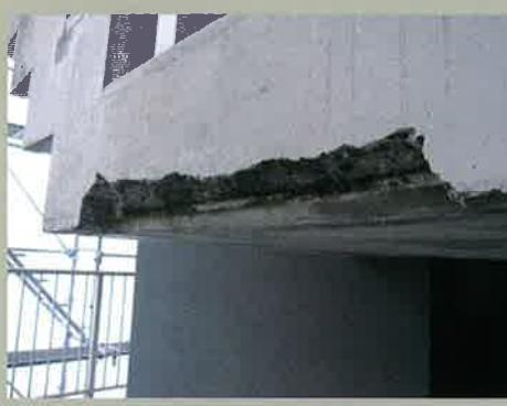
浮き部をはつり、鉄筋の防錆処理を施した後、Sクリートアップを塗布。Sクリートアップの効果によりコンクリートの改質・緻密化、アルカリ性回復。また、補修モルタルとの接着性が増強される。
