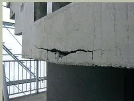
鉄筋が錆びて爆裂している様子。
