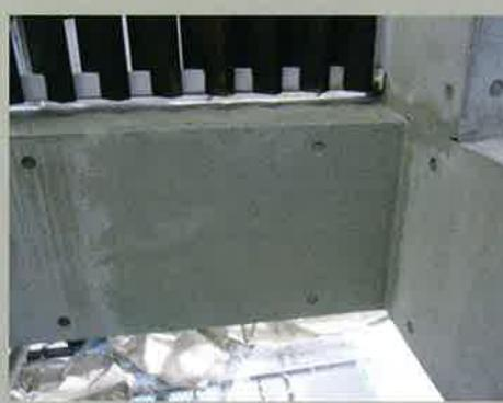
コンクリートの補修(改質)のため、Sクリートアップを塗布後、Sクリートクラック(超微粒子セメント)にて、表面被覆補修をする。Sクリートアップの効果にて、強靭な接着性が保たれる。
