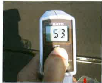
断熱αコート未施工面53°C
