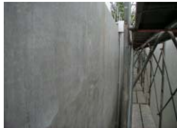
剥離洗浄完了
