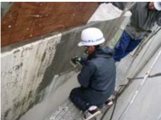
温水剥離状況
