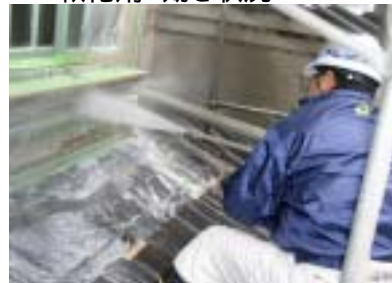
温水剥離1回目状況
