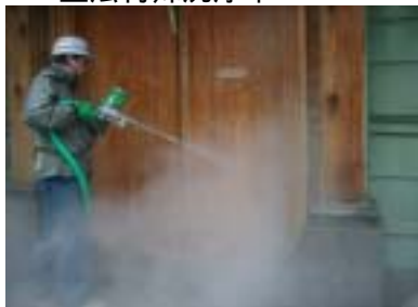
温水剥離3回目状況
