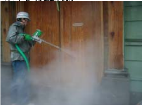
白亜塩調合ペイント下地14層 剥離温水洗浄
