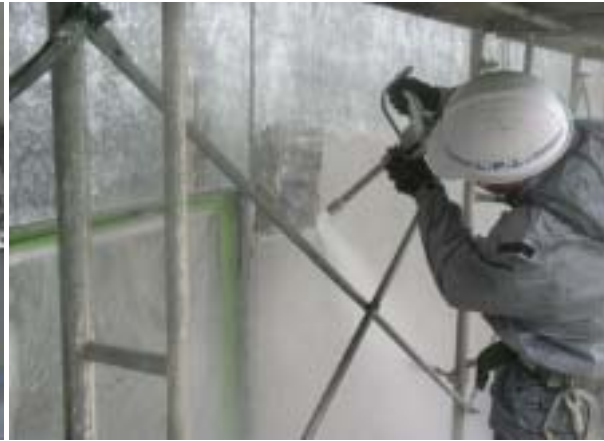
吹付けタイル下地 剥離温水洗浄
