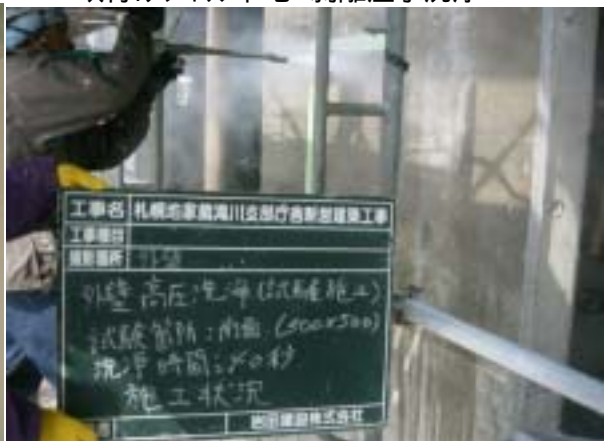
コンクリート目粗し 洗浄
