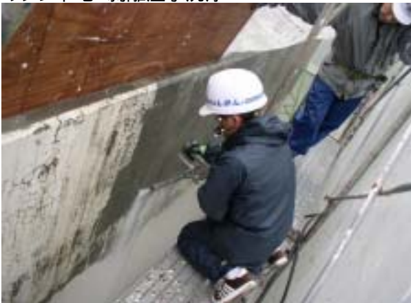
AEP下地 剥離温水洗浄
