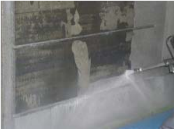
石目調吹付け下地 剥離温水洗浄
