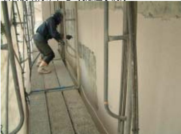
リシン下地 剥離温水洗浄
