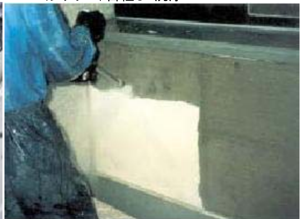
単層弾性下地 剥離温水洗浄
