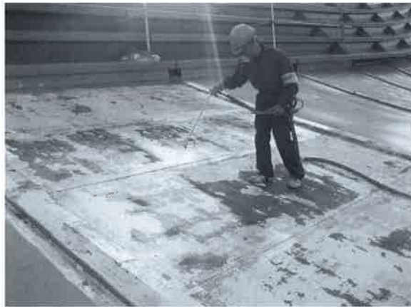
写真26 2回目の剥離剤(軟化剤)塗布。
