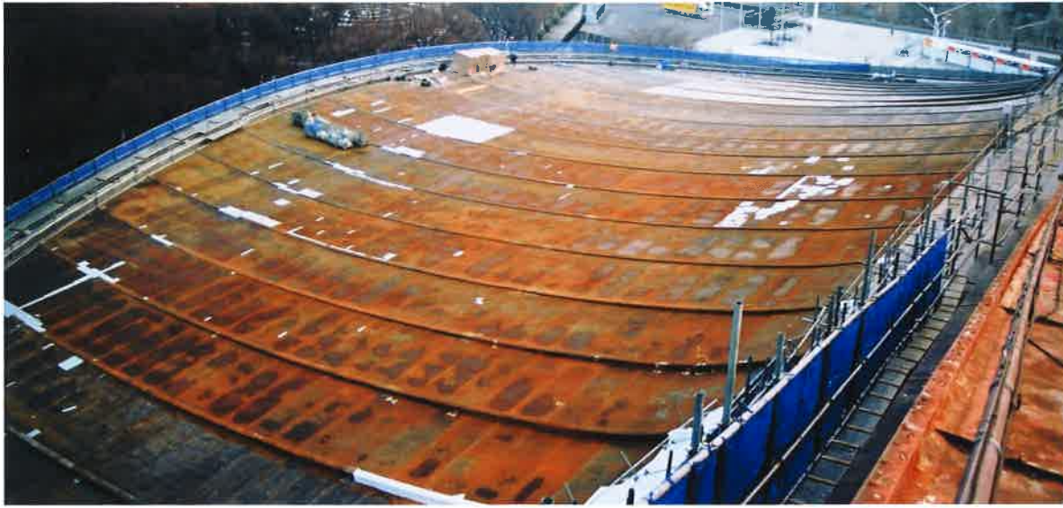
写真15 旧塗膜の剥離作業がほぼ終了した第一体育館の屋根。白い部分は慎重な下塗りを要する箇所の下塗り部分。
