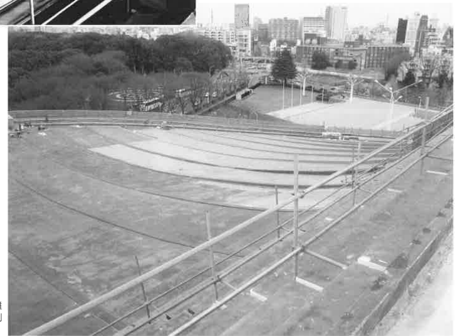
写真13 北東側面屋根部での剥離作業。
