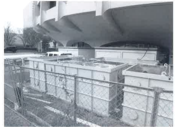
写真33 清水建設では塗膜剥離洗滌水を大型水タンクに集め、濾過し再利用するエコタイプの循環システムを実践した。
