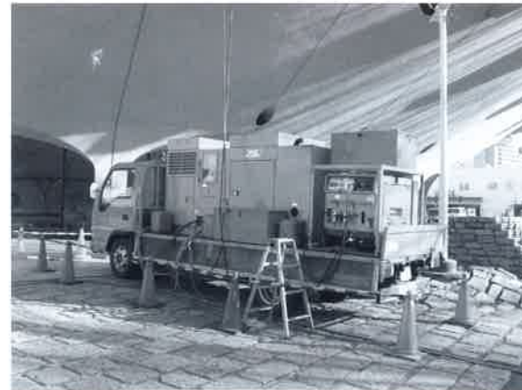
写真32 剥離作業の心臓部ともいえる超高圧洗滌車。
