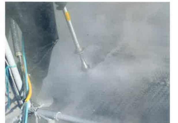
写真23 高圧での剥離作業。
