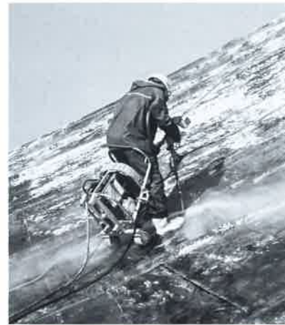
写真31 斜面上的剥離作業風景。
