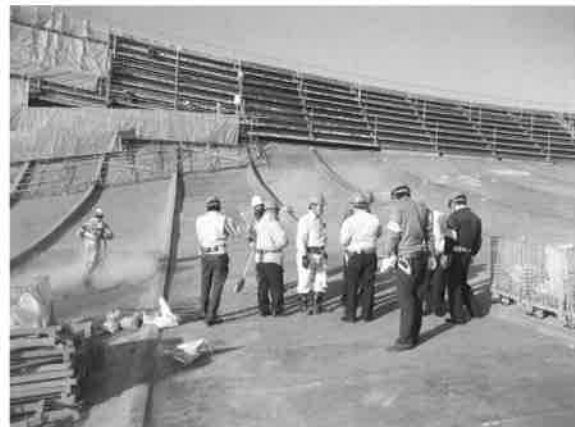
写真11 工事終了まで、何度も現場での密接な打合せと作業確認が行われた。
