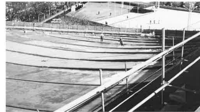
写真13 北東側面屋根部での剥離作業。
