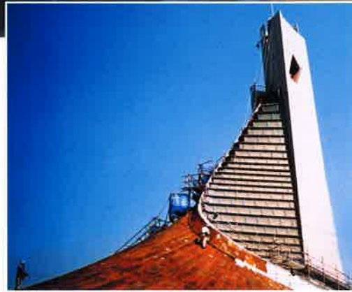
写真2 第二体育館頭頂部での剥離作業
