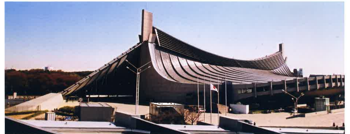
写真7 工事を終え綺麗になった第一体育館の全景。第二体育館から北東方向を見る。
