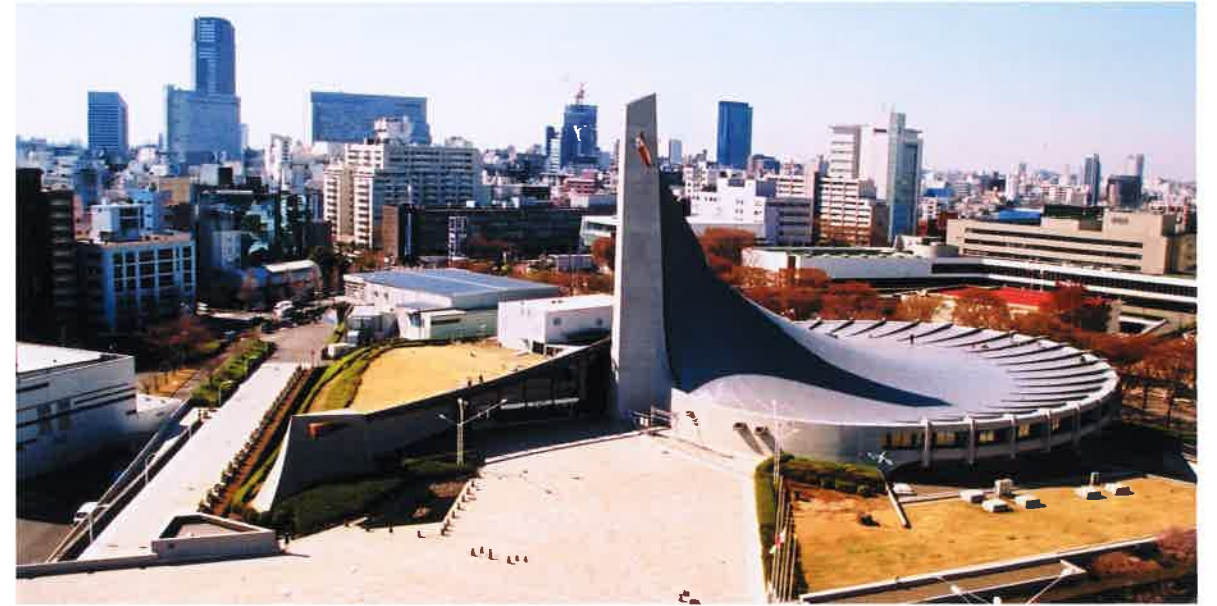
写真5 仕上がった第二体育館の屋根部(第一体育館から南西部を見る)
