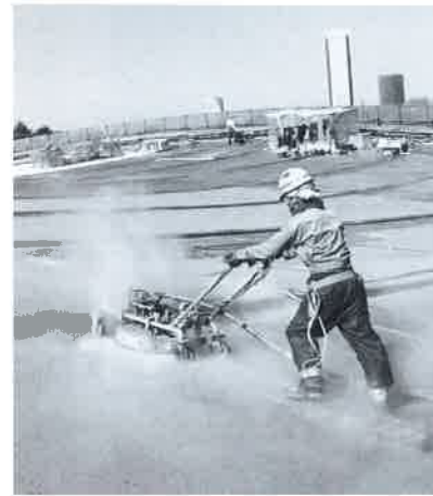
写真30 剥離機械での作業風景。
