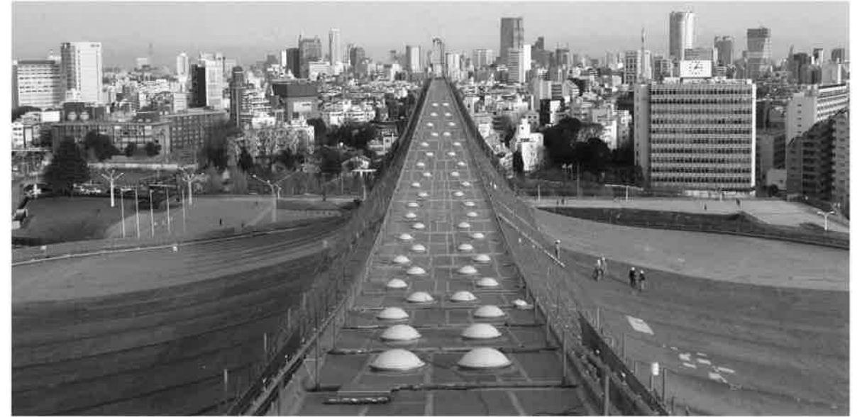
写真12 第一体育館の頭頂部付近から東側(渋谷)方向の眺め。半円形の帽子状のものは採光器。
