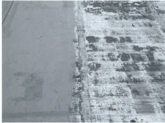
写真24 右半分が1回目の剥離を終えた部分。
