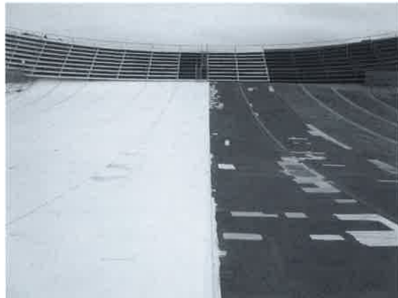
写真27 剥離作業後、劣化が顕著な部分に予め施された下塗り塗料。
