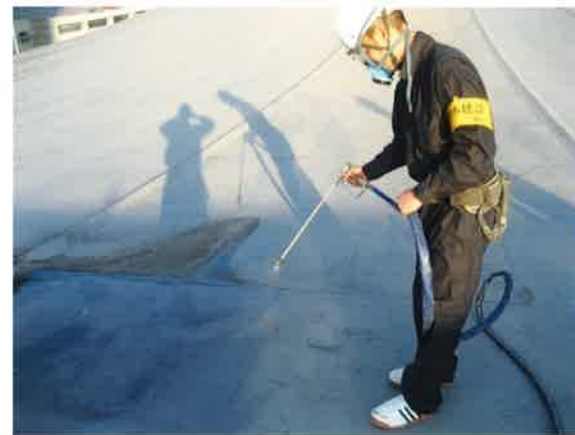
写真20 1回目の剥離剤塗布。
