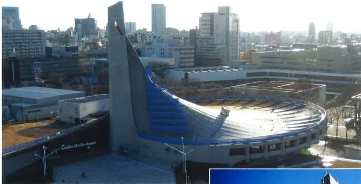
写真1 第二体育館での剥離作業風景。
