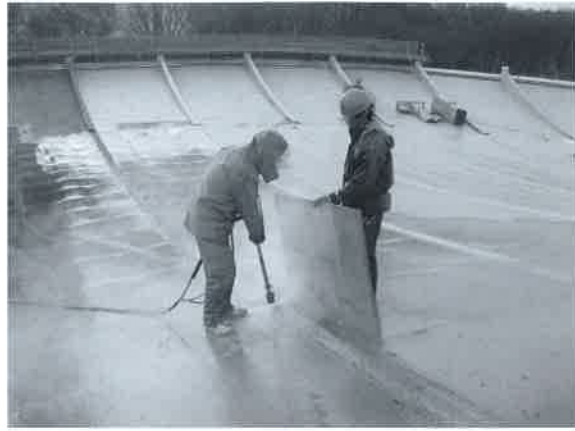
写真25 剥離作業の様様。
