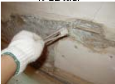
ボンディングプライマー素地固め
