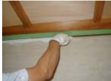
切り付けエラスティック充填
