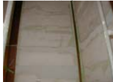
浮き劣化部エラスティック扱き
