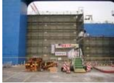
中防ケーソン作業所
