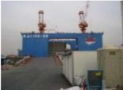
中防ケーソン作業所
