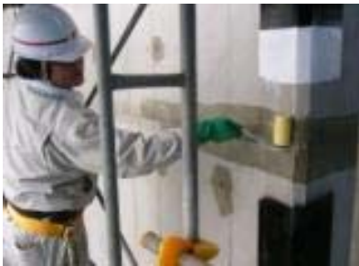
ナノコンシーラ塗布状況
