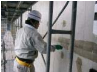
ナノコンシーラ塗布状況
